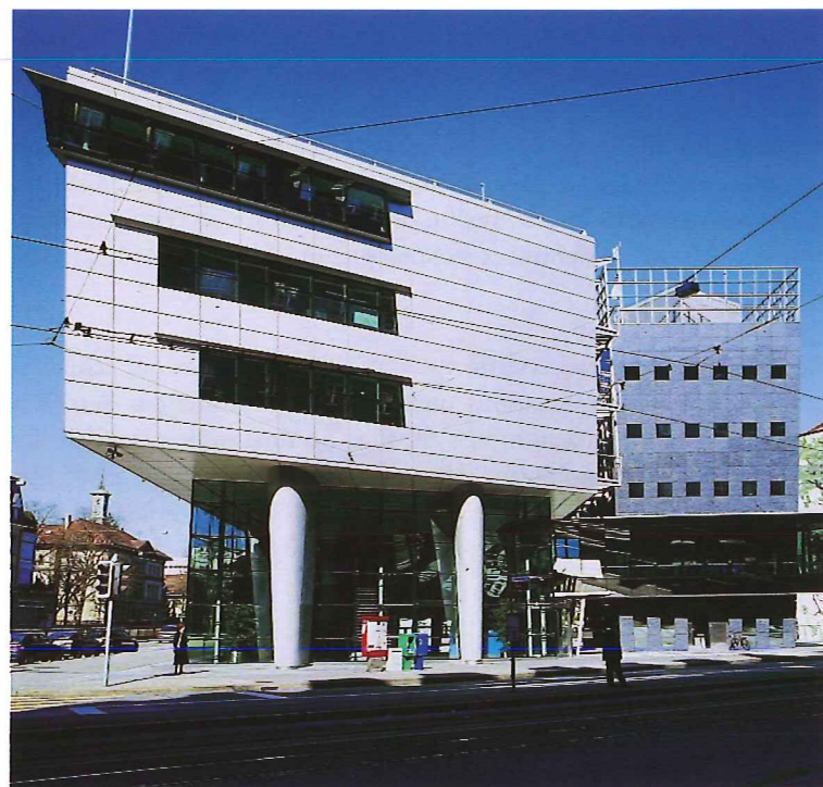
Bâtiment « Titanic II » - Est
